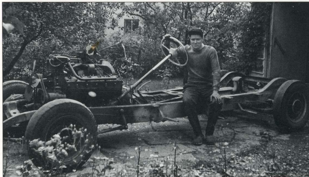
Bilden ger en god uppfattning om chassiets och motorns väl tilltagna dimensioner hos en Packard 1408, som var 1936 års största chassityp. (Foto från Olof Ulander.)
